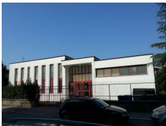
Sede di via S. Botticelli Telefono: 0776 270047
