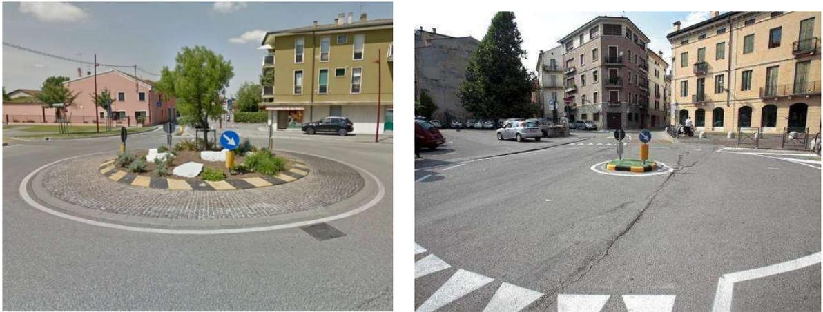
Figura 3-6. Esempi di mini-rotatorie in ambito urbano con isola centrale parzialmente sormontabile e non sormontabile.
