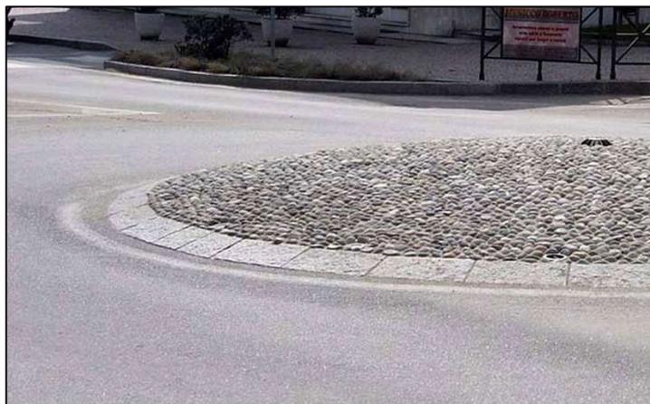
Figura 3-7. Un’isola centrale completamente sormontabile realizzata con ciottoli in rilievo, in modo tale da arrecare disagio alle autovetture che la percorrano.
