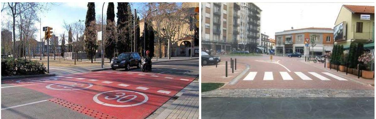
*Figura 3-16. Ingresso Zona 30 mediante platea rialzata o pavimentazione diversificata.*
